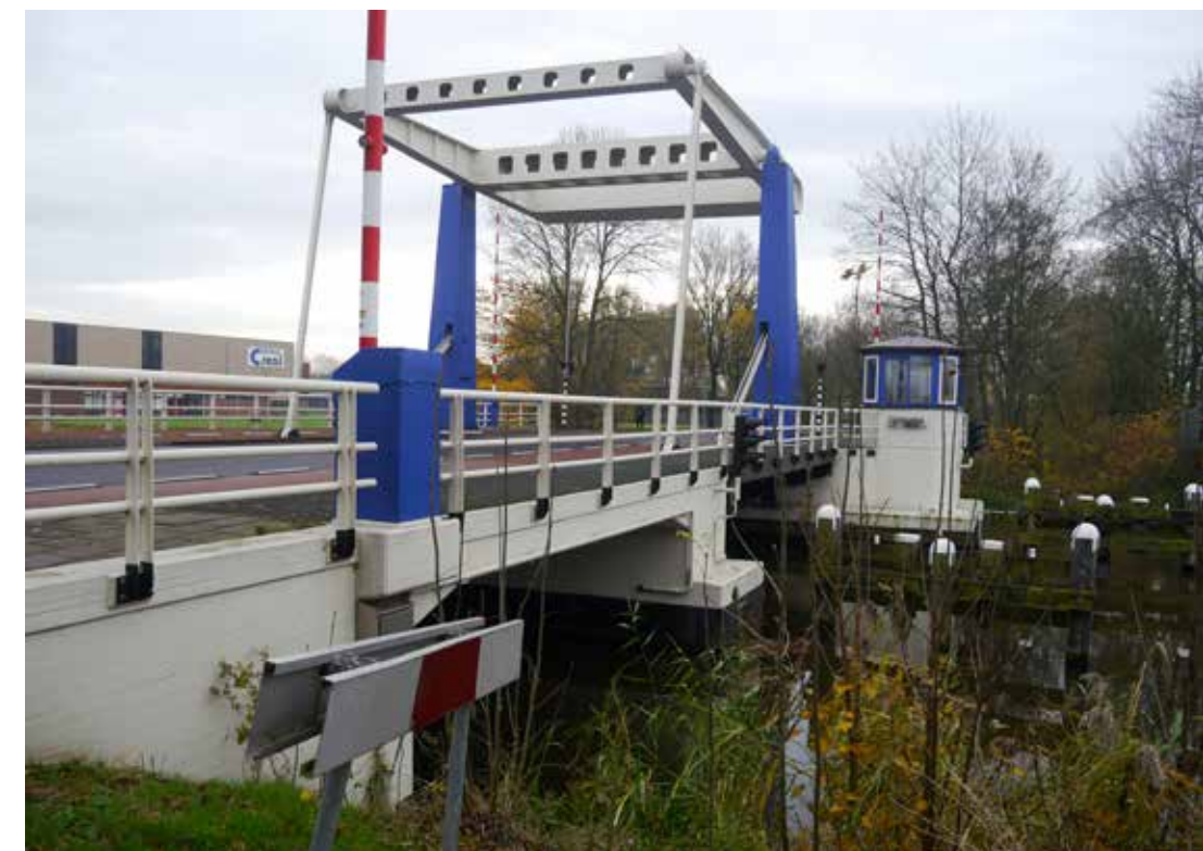
Het creëren van veilige weg- en brugdekken heeft de hoogste prioriteit bij HIM.
